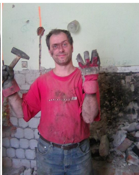
Faťa při rekonstrukci
