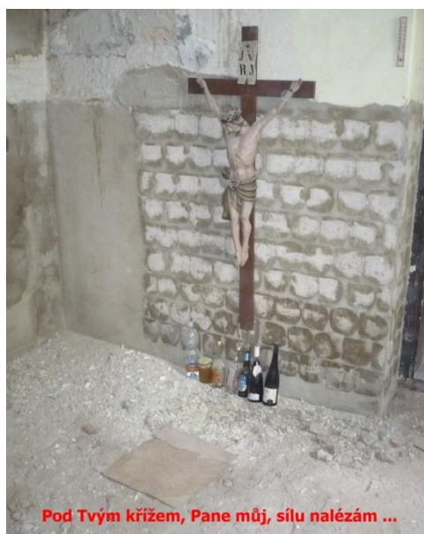
Fara při rekonstrukci
